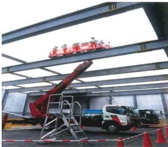
↑ 高所作業車の試乗
